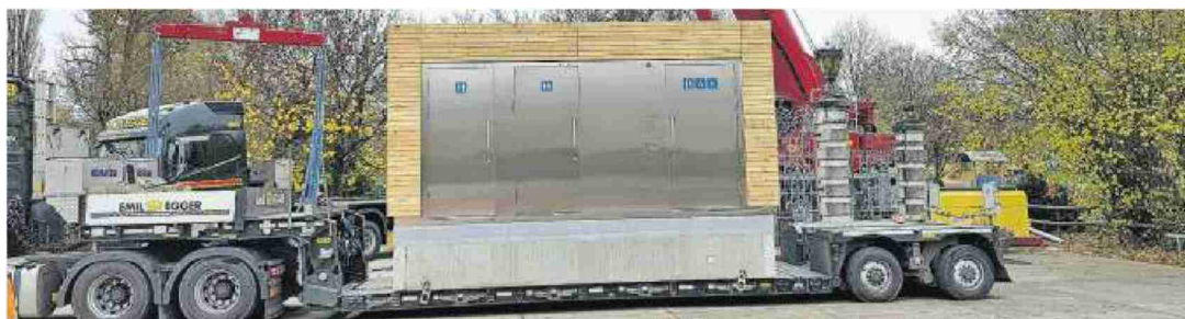
Die neue WC-Anlage wurde vergangenen Mittwoch angeliefert.
