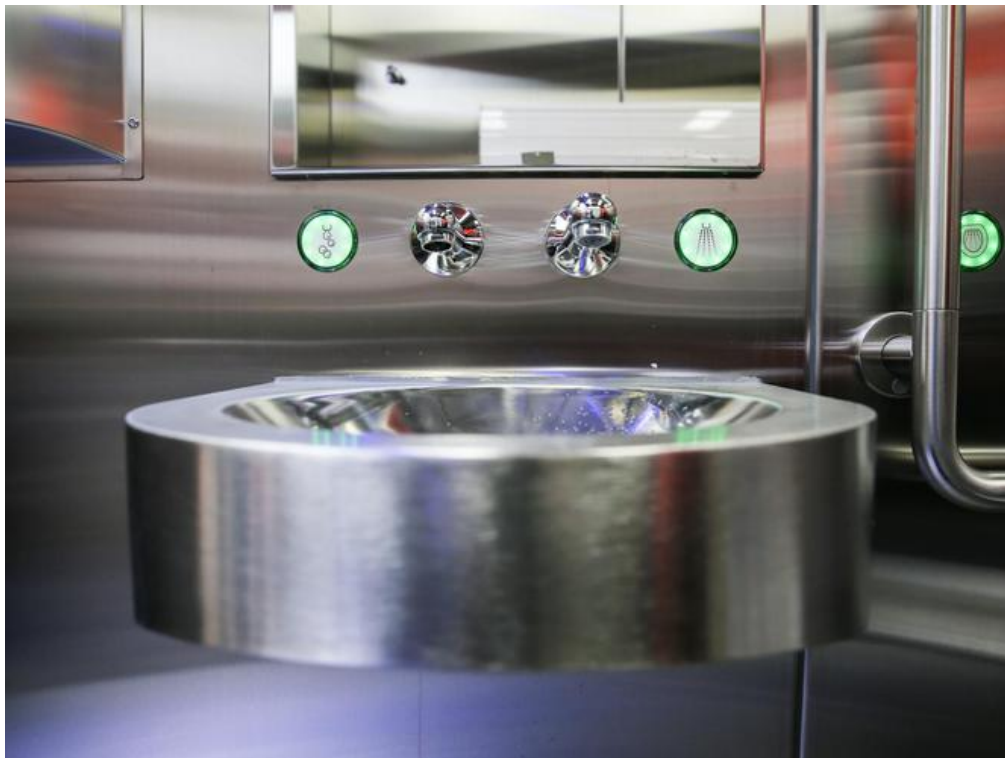
Die Bedienung der Apparaturen ist sensorgesteuert: Ein kleines Tippen mit dem Finger genügt. (Bild: Nathalie Guinand)
